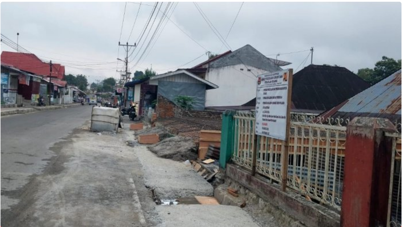
Proyek Drainase Kabun Pulasan Kota Bukittinggi bobot baru sekitar 25 % pengerjaannya
